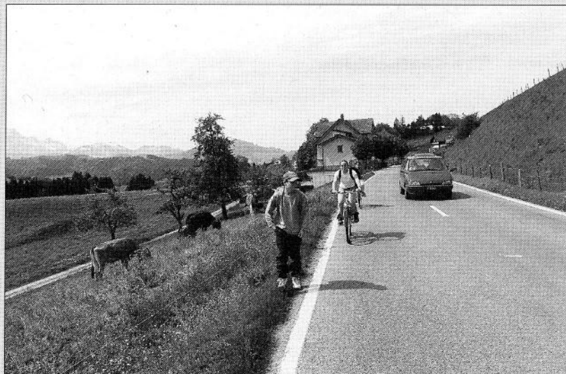
Gefährliche «Idylle»: Die trottoirlose Speicherstrasse im Bereich des Schulhauses Gählern. Foto: GL
