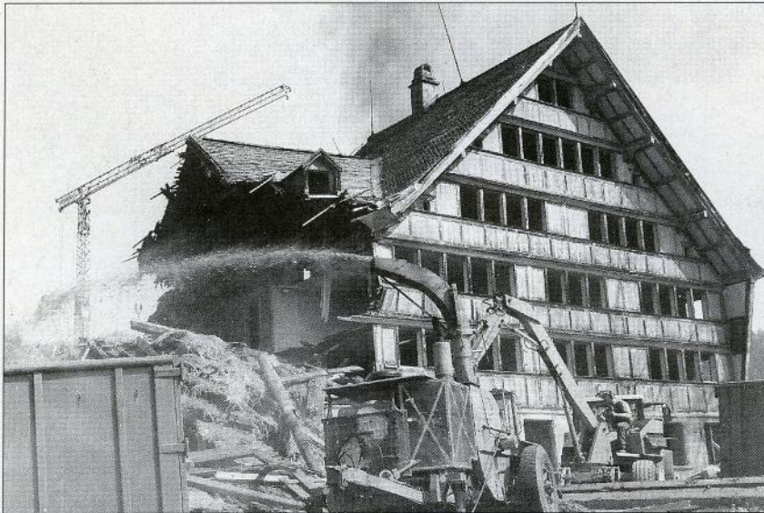
Der Abbruch ging zügig voran.
