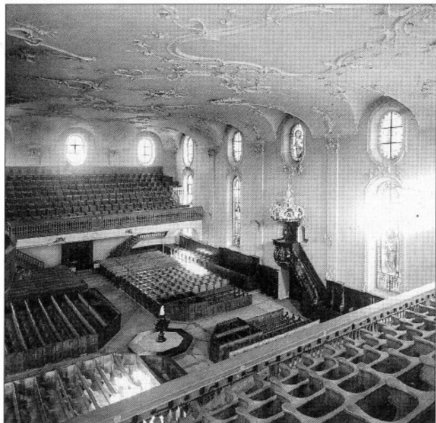
Kirche Wädenswil 1764/67 mit dem grossen stützenfreien Predigtraum.
