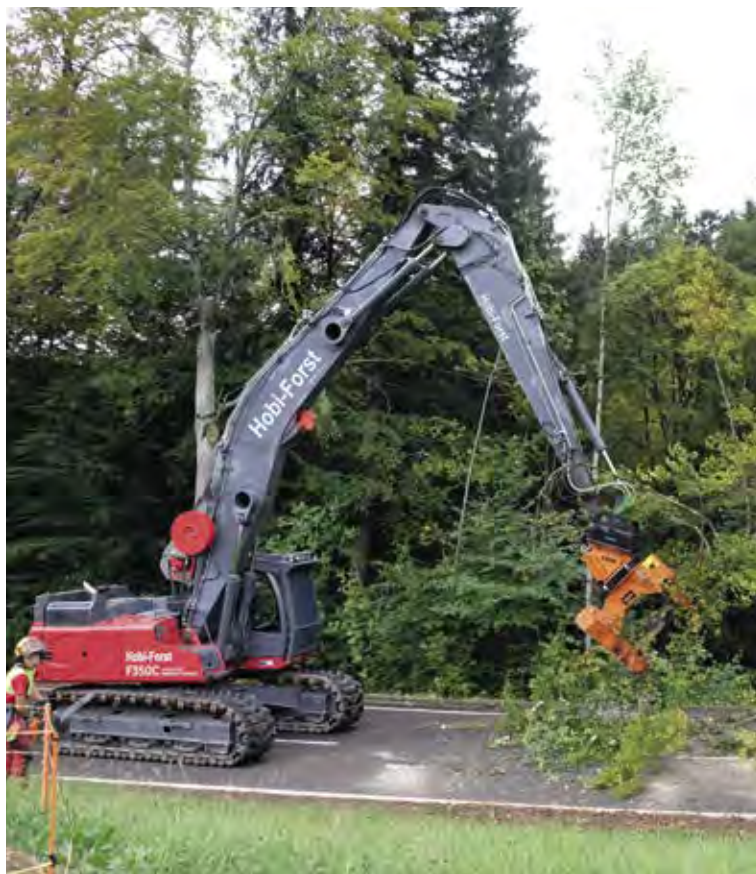
Der Einsatz des 35 Tonnen schweren Fällbaggers lohnt sich hier..
