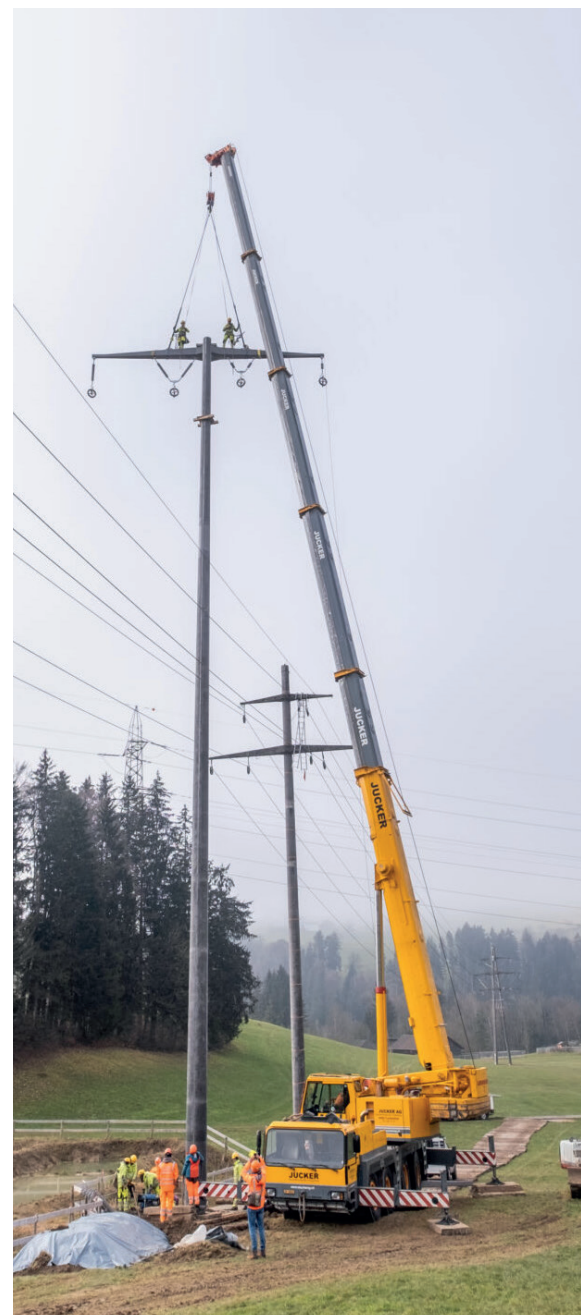
Oben angekommen montieren die zwei SAK-Mitarbeiter zuerst die Schalung. Fotos: tiz
