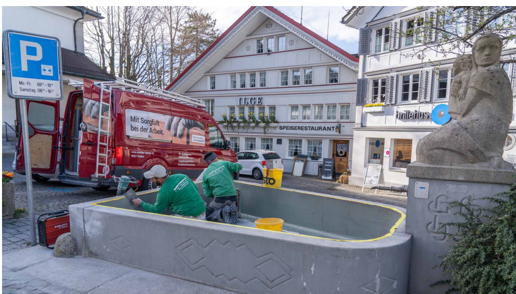
Nach dem Abschleifen kommt nun die Dichtungsmasse drauf. Foto: nek
