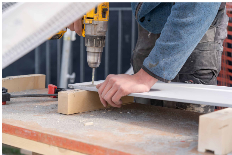
Platte für Platte bekommt die Fassade der Turnhalle Landhaus ein neues Kleid.
