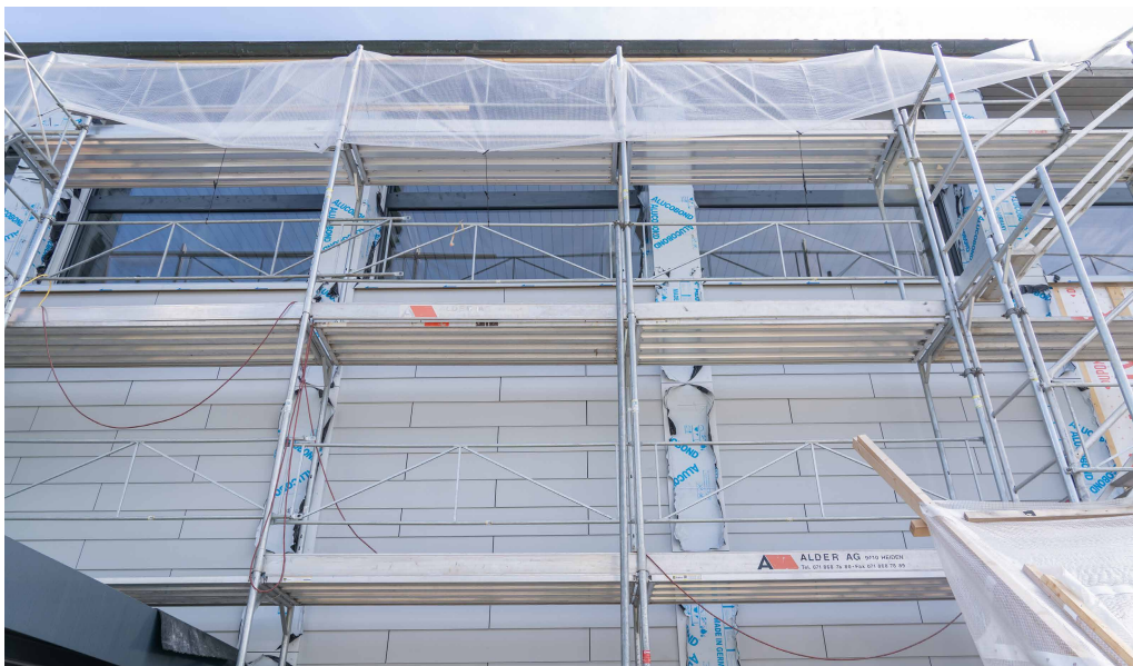
Die fertige Fassade ist schon gut sichtbar. Die hellgrauen Zementfaserplatten wurden zuletzt montiert. Fotos: nek
