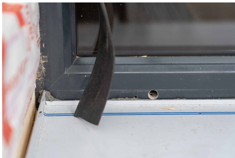
Die Fenster wurden angepasst, damit die korrekte Entwässerung sichergestellt ist.
