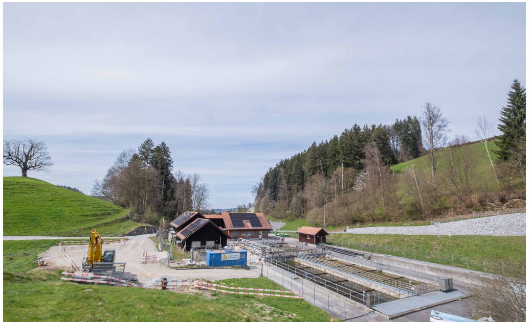
Im September soll aus der ARA Mühltofel ein Rückhaltebecken werden – das Teufner Abwasser wird ab dann in der ARA Au in St. Gallen gereinigt. Der Weg dahin führt über zwei Brücken. Foto: tiz
