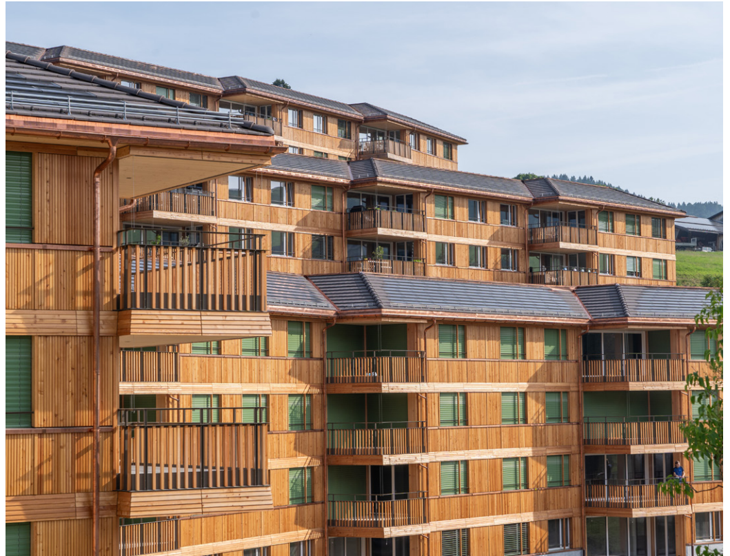
Die Überbauung Sammelbüel schmiegt sich auf einzigartige Weise in den steilen Hang ein.
