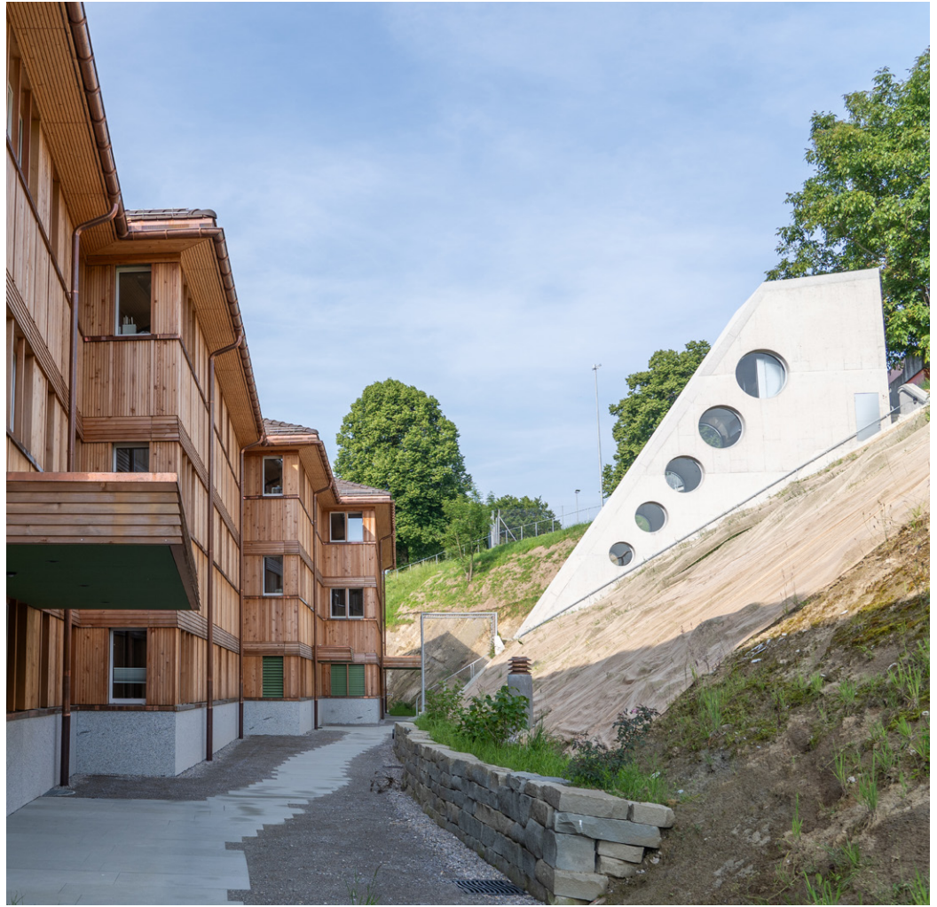
Der Schräglift verbindet alle Wohneinheiten und den Zeughausplatz mit der Goldibrugg-Strasse.
