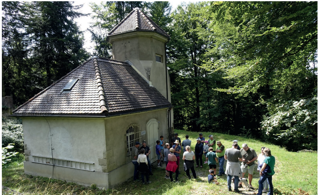
Besuch beim Pumpwerk Sommerhütte – erbaut 1912. Foto: Esther Schöpfer
